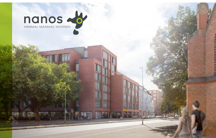
Zweites nanos-Gebäude — bereits im Dezember 2019 werden hier die ersten Mieterinnen und Mieter einziehen.
