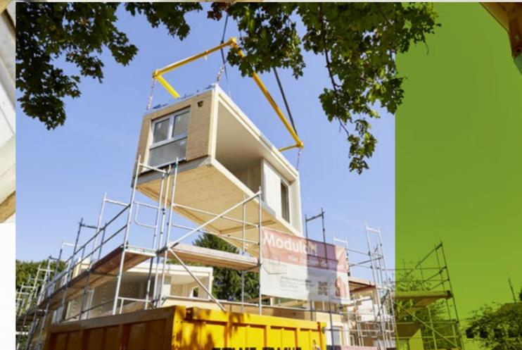
**Hier wird gestapelt:** Wie bei einer Mischung aus Tetris und dem Baukastenprinzip wurden die einzelnen Holzmodule vor Ort mit dem Kran an ihre endgültige Stelle platziert.
