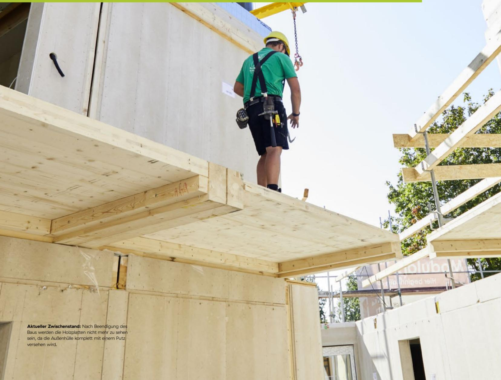
**Aktueller Zwischenstand:** Nach Beendigung des Baus werden die Holzplatten nicht mehr zu sehen sein, da die Außenhülle komplett mit einem Putz versehen wird.
